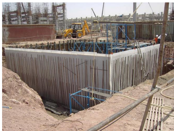
Revestimento Sure Grip® em ECTFE fixada às ferragens e escoras civis, antes de receber a concretagem.
