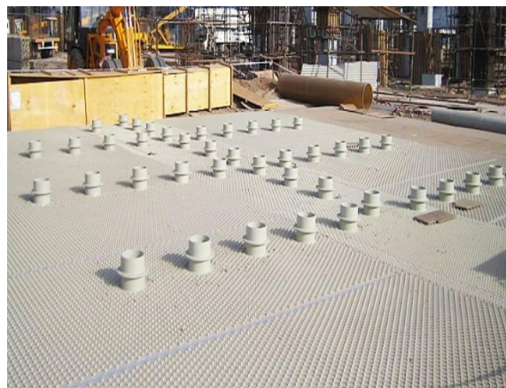
Montagem do revestimento para o teto da estrutura com Sure-Grip® e tubos em PP.
