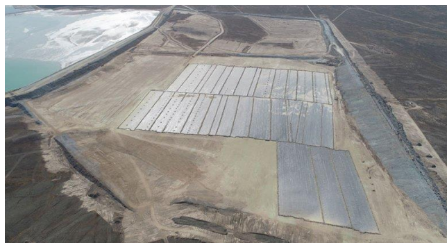
Instalación de las geomembranas para la lixiviación de las pilas
